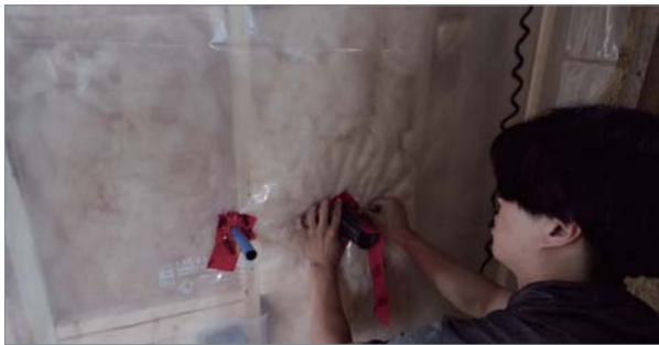
Conventional Wall의 내부 기밀/수증기막이다. 배관 테이프 작업을 하고 내부는 투습되지 않는 덕테이프로 마감을 꼼꼼히 해야 한다. 오른쪽으로 검은색 Acoustic Seal을 볼 수 있다.
