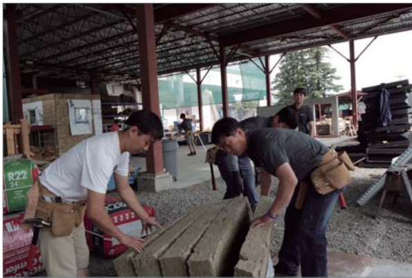
실습 마지막 일정은 외부 단열재와 중공 단열재, 기밀/수증기 막 설치로 마지막 테스트를 앞두고 주택의 시스템을 설치하는 마무리 공정이다.
