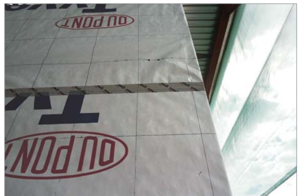
정확한 내후/기밀막을 설치하려면 접합부를 테이프로 마무리 해서 연속된 막을 형성해야 한다.
