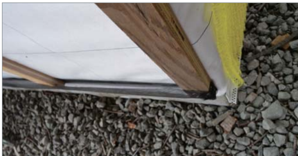
Conventional Wall의 Rainscreen에는 PVC 재질의 자재로 벌레 방지망을 설치했다.
