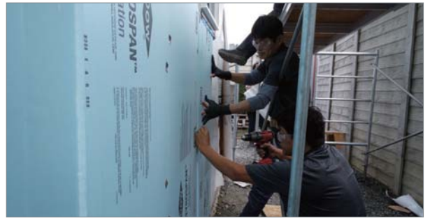
Advanced Wall의 외부 단열재는 XPS를 취부했다. 단열재의 두께를 높이기 위해 OSB를 설치하지 않는 곳은 그 두께 만큼 두꺼운 XPS를 쓸 수 있다.
