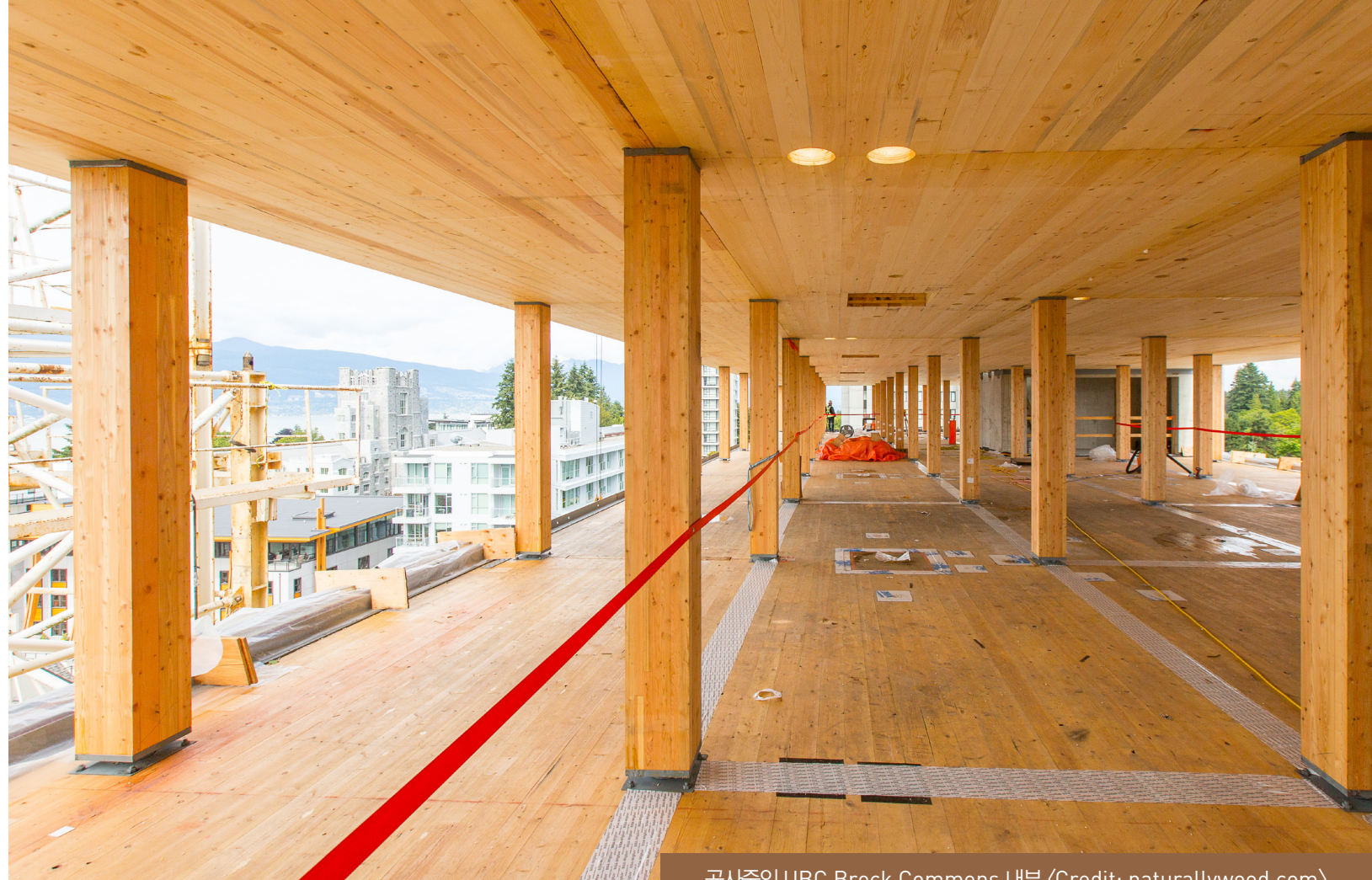
공사중인 UBC Brock Commons 내부 <Credit: naturallywood.com>
